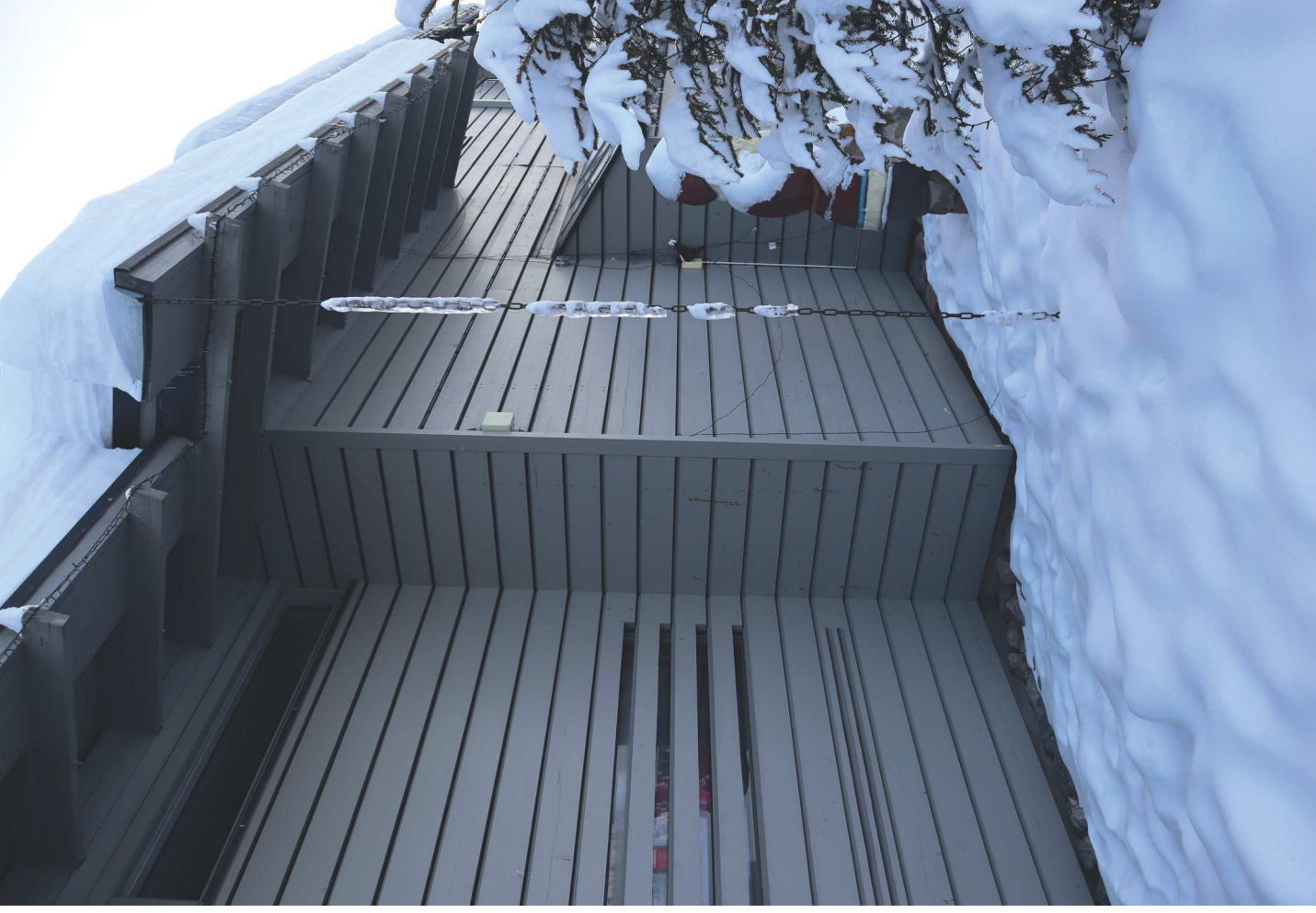
Ikkunoita on myös verhouksen takana. Nämä ikkunat ovat lähellä pohjoisjulkisivun vesikaton sadekourusta johtavaa sadeketjua.
